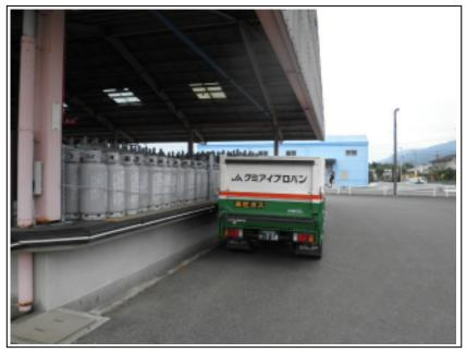
トラックがボンベ積み降ろし時にプラットホーム へ追突した場合の衝撃を緩和するため、ゴムの緩衝 材を設置している。
